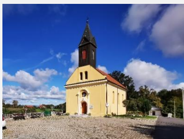
Slika 9. pristupni trg i kapela (26. rujna 2019.)
